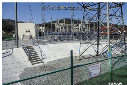
変電所内 フェンス工事・ 防草シート工事
