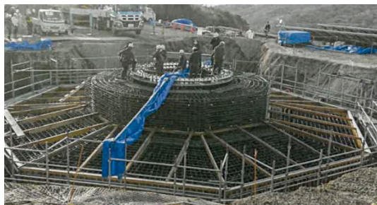
タワー基礎工事
