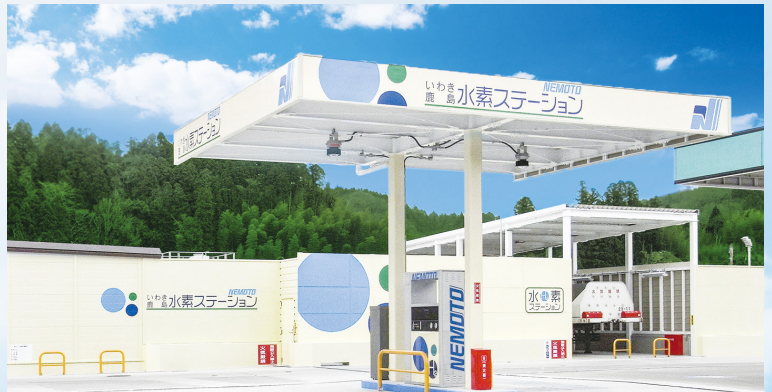
水素ステーション
